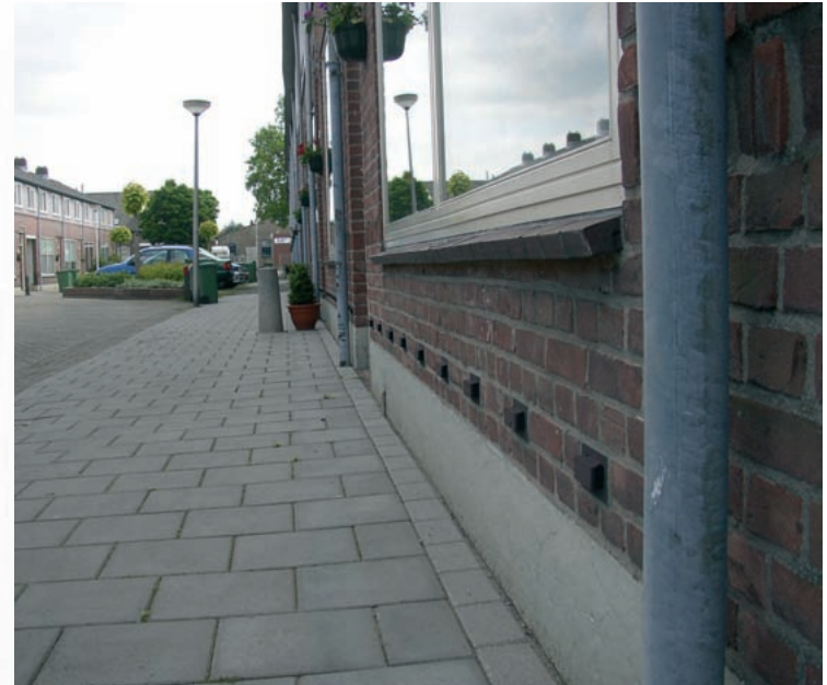
De ontluchtingskanalen van de elementen steken iets uit.
