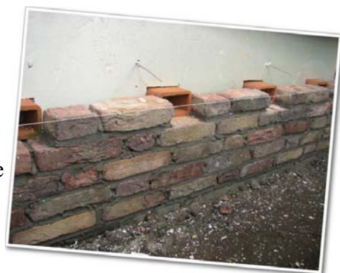
Das System in einem Gebäude im Bau. Die Keramikelemente sind sichtbar.
